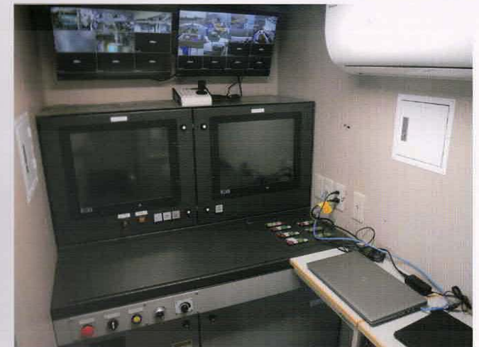
機関監視区画 Engine monitoring space
